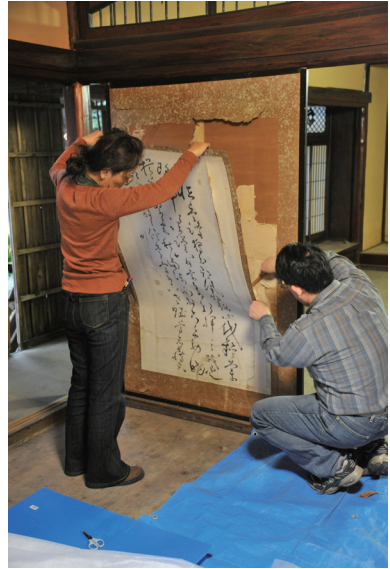
写真13 本紙取り外し作業
